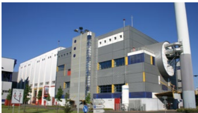
Centre de valorisation thermique de Neunkirchen - Allemagne.
