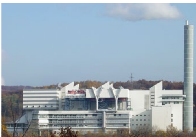
Centre de valorisation thermique de Velsen - Allemagne.
