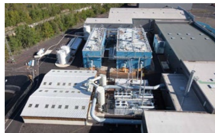
Méthavalor : vue sur les digesteurs.
